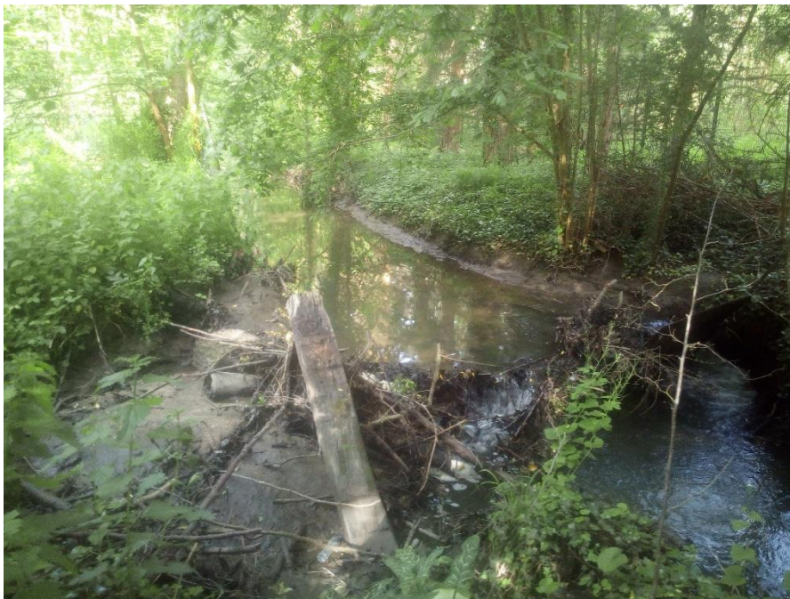
Batardeau (Zone 2 Photo 2)
